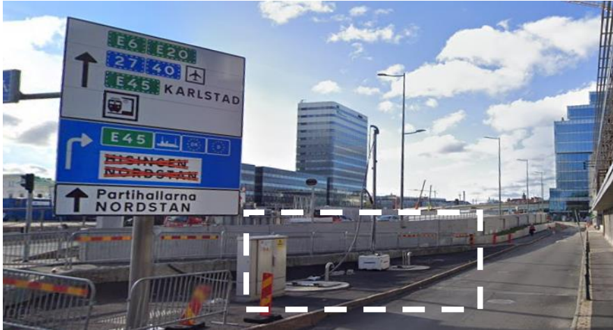
Figur 38. Bild visar befintlig spillvattenpumpstation vid Kilskatan.
